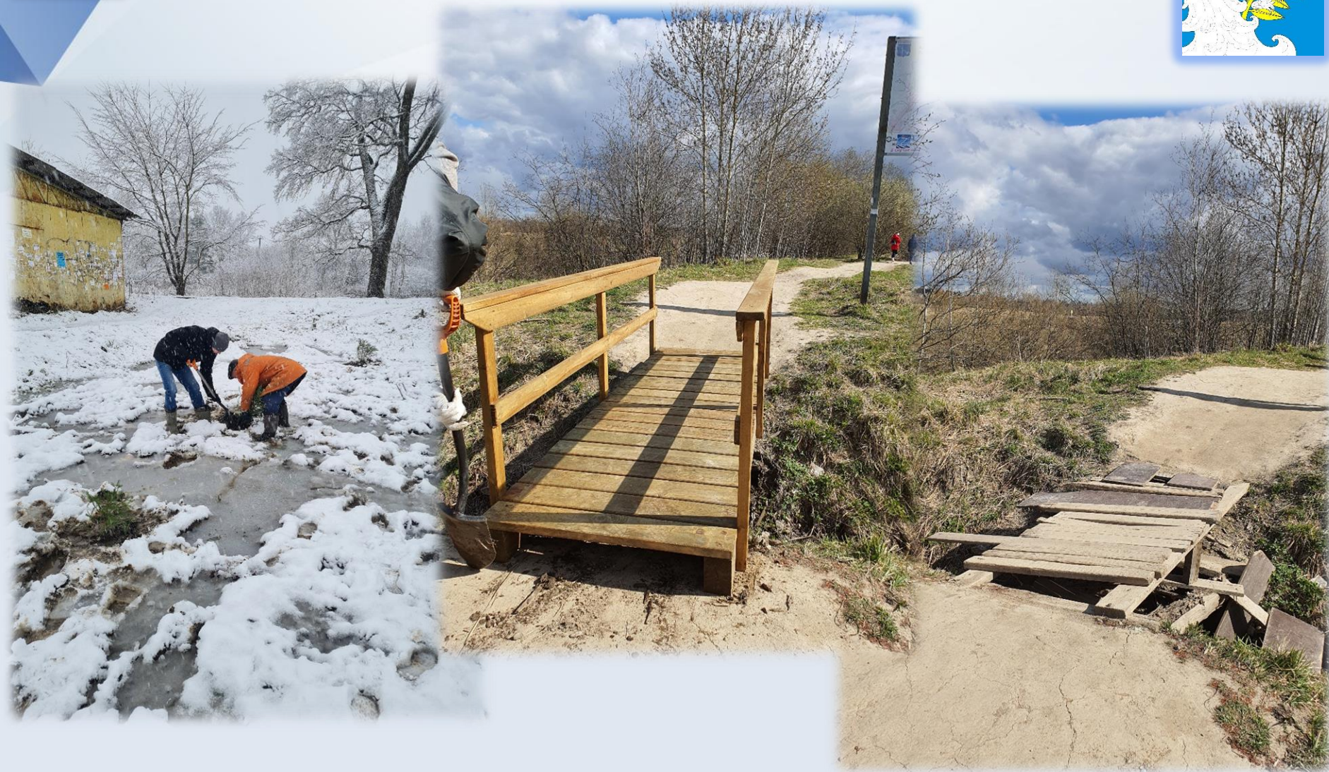
Посадка деревьев, ремонт моста у Тосненского водопада.
