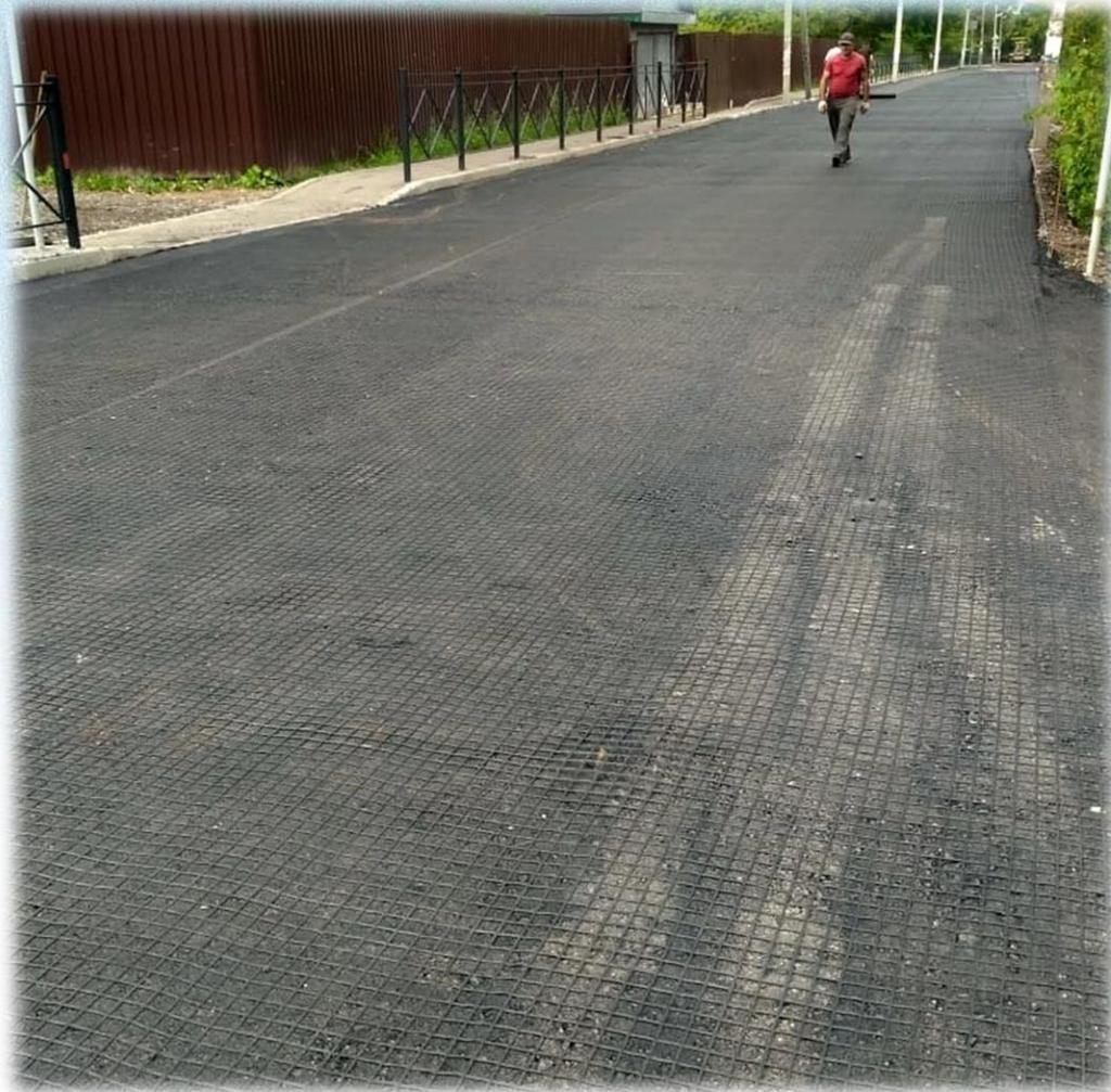
Использование специальной полиэфирной сетки при ремонте ул. Колпинской
